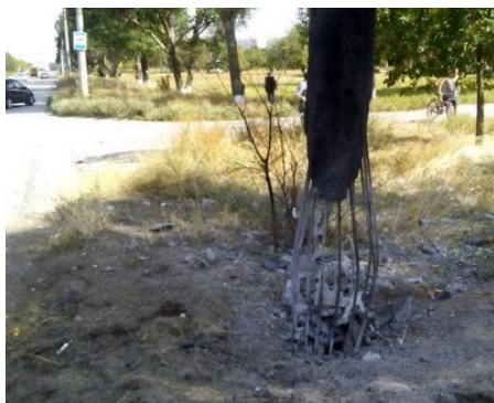
Фото 41. Наслідки спрацювання СВП, маскованих у дорожнє покриття та стовп
