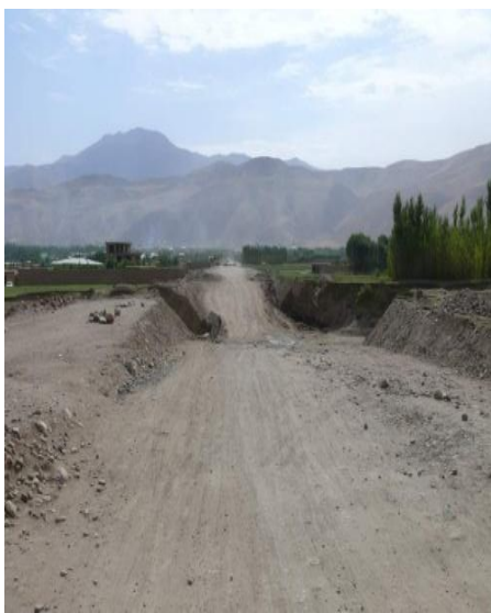
Фото 37. Ділянки звуження доріг.
