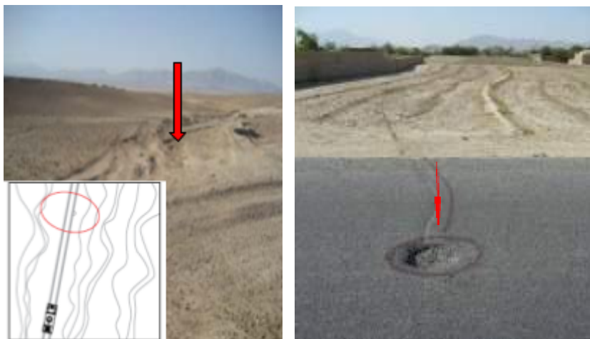
Фото 38. Встановлення СВП у м'який ґрунт
